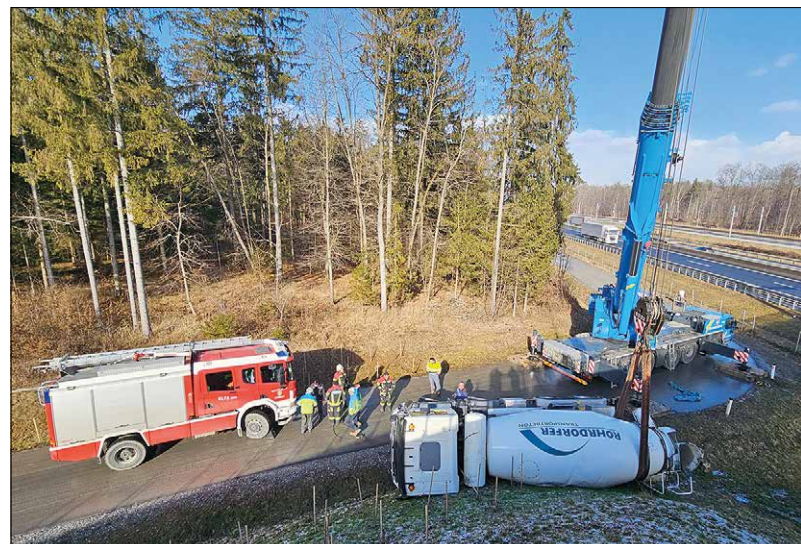
Einen spektakulären Einsatz verursachte ein umgekippter Betonmischer. Dieser musste von einem 400-Tonnen-Kran geborgen werden.
