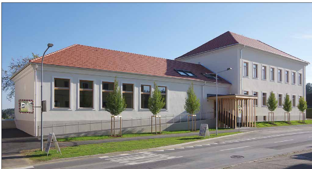
Der behindertengerechte Zugang für die externe Turnsaalnutzung mit neuer Bushaltestelle.
