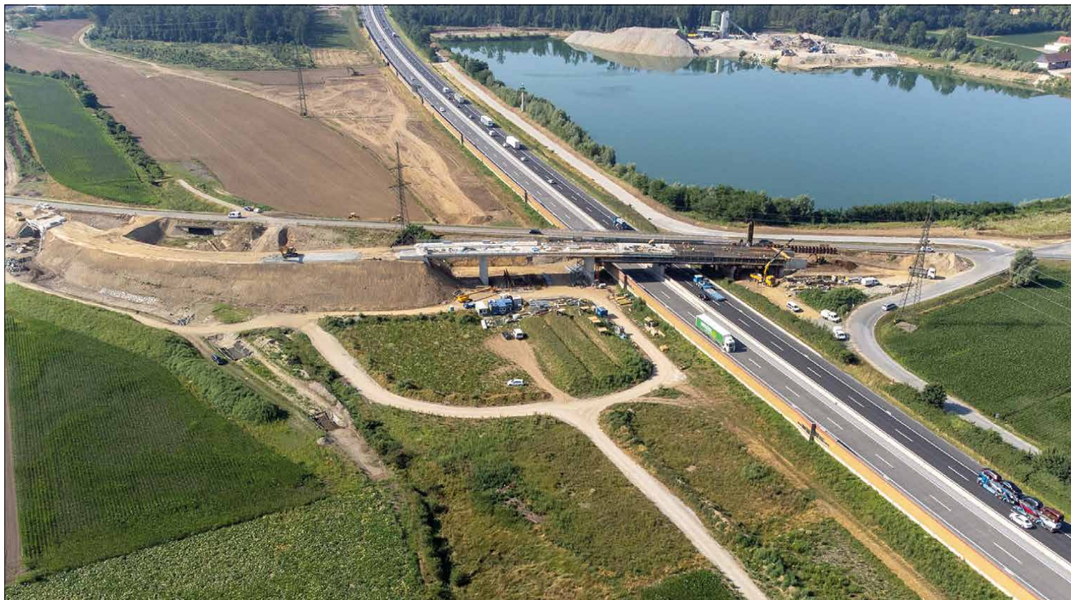
Die Werndorfer Brücke ist mit den beiden Kreisverkehren und dem Anschluss der A9-Begleitstraße das aufwändigste Bauwerk.
