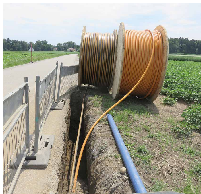
Vom Sonnenweg bis zum Ortsanfang von Ponigl werden Glasfaser-Leerverrohrungen verlegt. Auch die Wasserleitung sowie die Kabel für die Straßenbeleuchtung werden mitverlegt.
