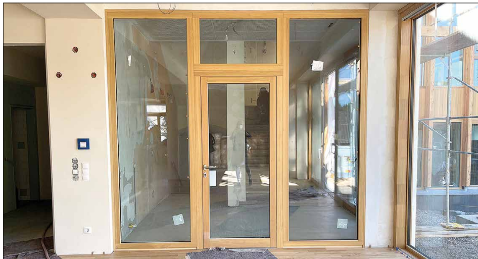
Im alten Schulgebäude kommt viel Glas zum Einsatz. Dadurch wird das Haus innen viel heller. Alle Fenster und Türen sind aus Holz.
