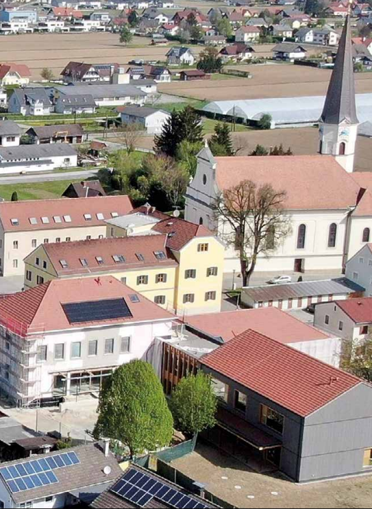
Auf dem Dach wurde eine Photovoltaik-Anlage mit 6 KWp installiert.
