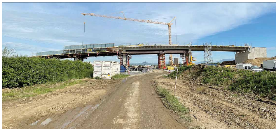
Die Autobahnbrücken wurden neu errichtet. Insgesamt führen jetzt vier Brücken auf Wundschuher Gemeindegebiet über die A9 und die Koralmbahn.
