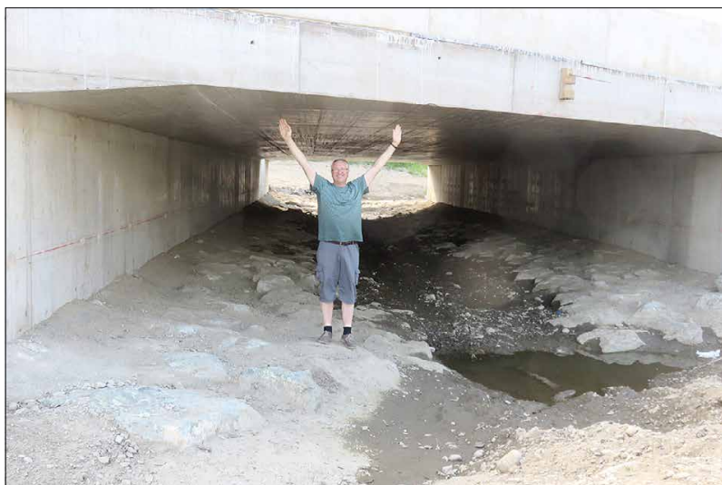
Die Koralmbahn überquert den Laabach und den Poniglbach. Beim Wandertag kann man diese Unterführung begehen.
