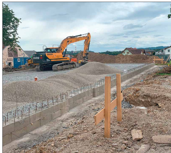
Eine stabile Fundamentplatte ist die Basis für die ökologische Bauweise mit Holz aus heimischen Wäldern.
