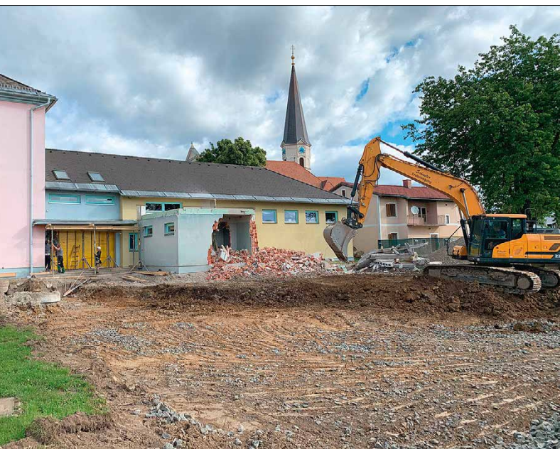
Die Sanitäranlagen inkl. Duschen für den Turnsaal wurden abgebrochen. Hier entsteht der neue Eingangs- und Garderobenbereich.
