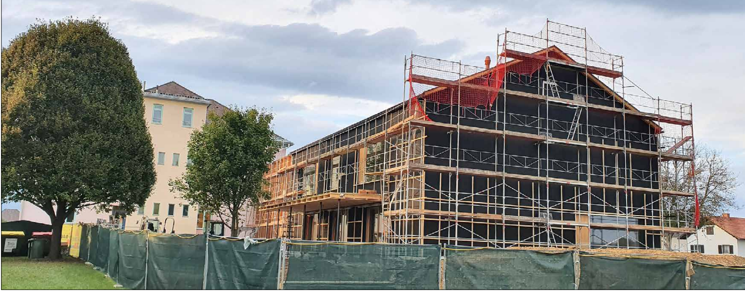
Noch steht das Gerüst für die Montage der Außenfassade, die ebenfalls komplett aus heimischem Holz gefertigt wird.
