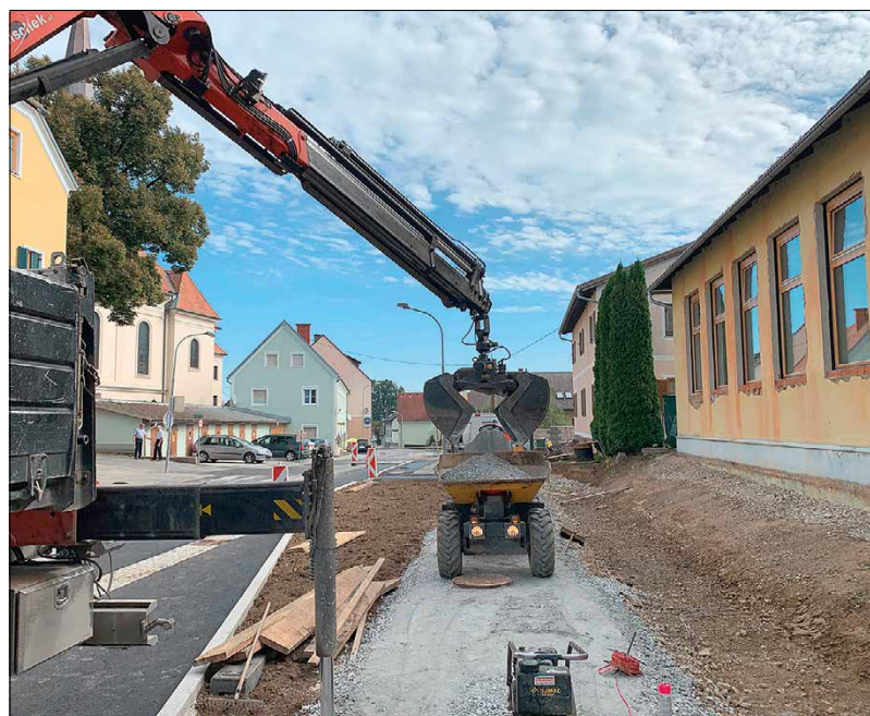
Die Bauarbeiten für die neue Bushaltestelle vor der Volksschule konnten größtenteils kurz vor Schulbeginn abgeschlossen werden. Die alte Bushaltestelle östlich davon wurde stillgelegt.
