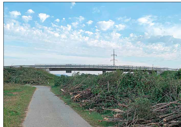
Mit den Rodungsarbeiten bei den Brückenrampen wurde bereits Mitte September begonnen.
