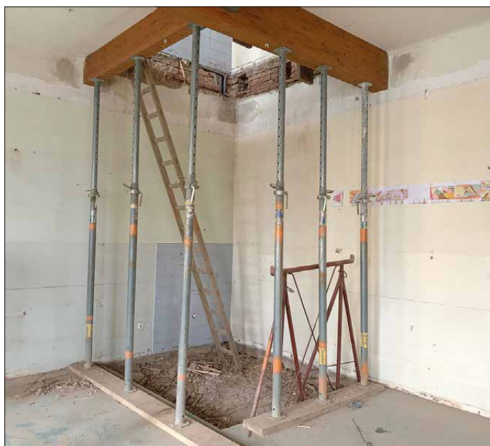
Mit dem Einbau eines Lifts über drei Stockwerke ist eine Vorgabe der Schulbehörde – nämlich die Barrierefreiheit – gewährleistet.
