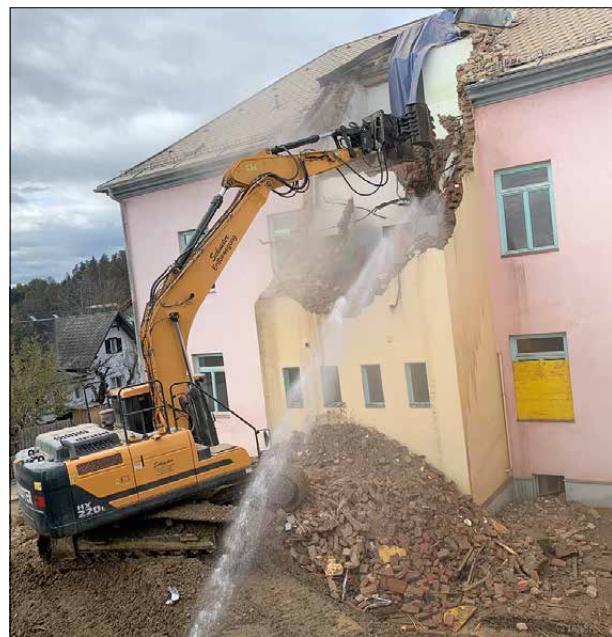
Der südlich angebaute Kubus, in dem vormals die Toilettenanlagen situiert waren, wurde vollständig abgebrochen.
