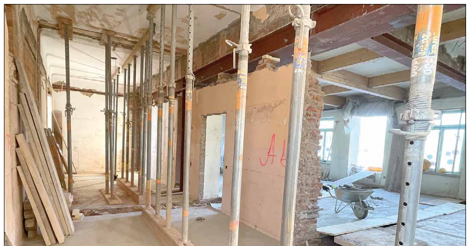
Viele Innenwände kommen weg, viele Stahlträger werden eingezogen. Der Innenbereich wird komplett neu gestaltet und bekommt größere, offenere Räume.
