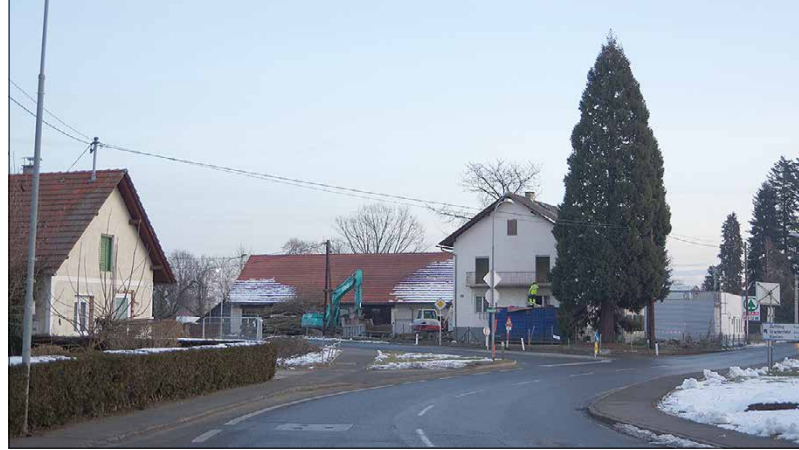
Dieses Foto wurde kurz vor dem Abriss des sogenannten Weber-Hauses im Jänner 2021 aufgenommen. Dahinter ist die Firma Spar.
