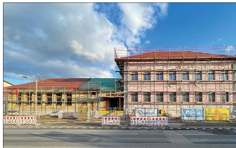
Das Dach des Turnsaals und des alten Schulgebäudes wird komplett neu eingedeckt. Auch eine Photovoltaikanlage wird installiert.
