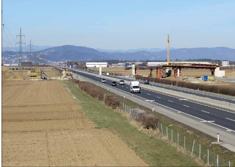
Die alte Autobahnbrücke in Gradenfeld wurde bereits abgerissen und der Neubau ist schon sehr weit fortgeschritten.
