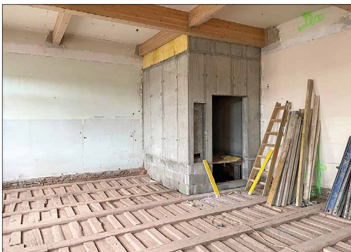
Hier sieht man die alte Tramdecke. Für den behindertengerechten Ausbau wird ein Lift eingebaut, der über alle Stockwerke geht.
