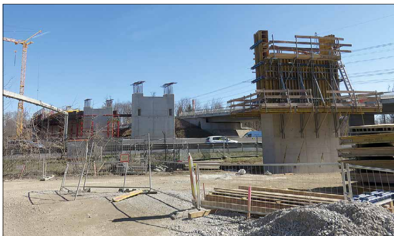
Auch die Brücke zwischen Weitendorf und Werndorf liegt auf Wundschuher Gemeindegebiet und wird völlig neu errichtet.
