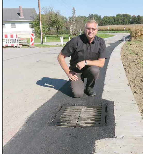
Ausbau der Ortswasserleitung in Ponigl und Entwässerung der Ponigler Straße.
