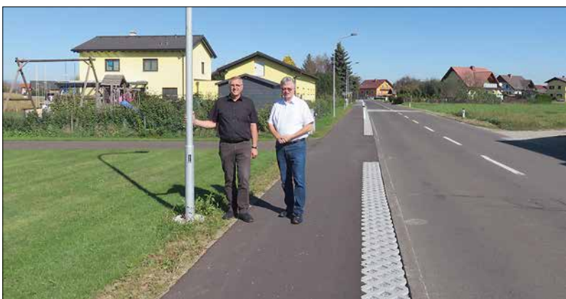
Vzbgm. Karl Scherz und Bgm. Karl Brodschneider: „In Kasten, Hauptstraße, wurde der Gehweg zwischen dem Kaiserwaldweg und dem Rainweg völlig neugestaltet und hell beleuchtet.“
