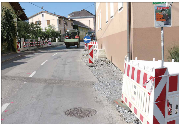
Durch den teilweisen Abbruch der ehemaligen Kirchenwirt-Stiege wurde eine Gefahrenquelle beseitigt.
