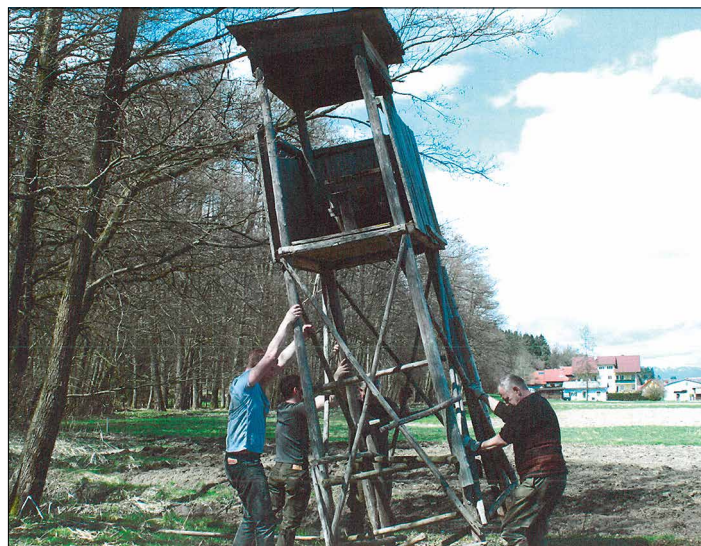
Aufstellen eines Hochsitzes in Forst.
