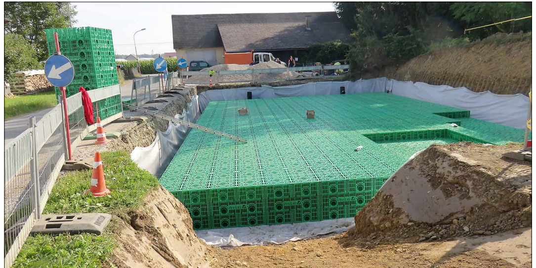
Zwischen der ESV-Halle und der Forster Straße wurde ein Rückhaltebecken für Oberflächenwasser aus dem Bereich Kulturheim/Sportplatz errichtet.
