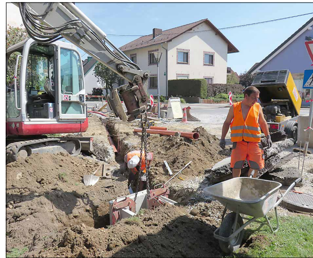
Auch die Regenwasserkanäle wurden im Zuge der Umgestaltung erneuert.
