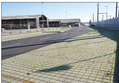
Am Bahnhof Kalsdorf können nach dem kräftigen Ausbau des Park & Ride-Parkplatzes 118 Autos abgestellt werden.
