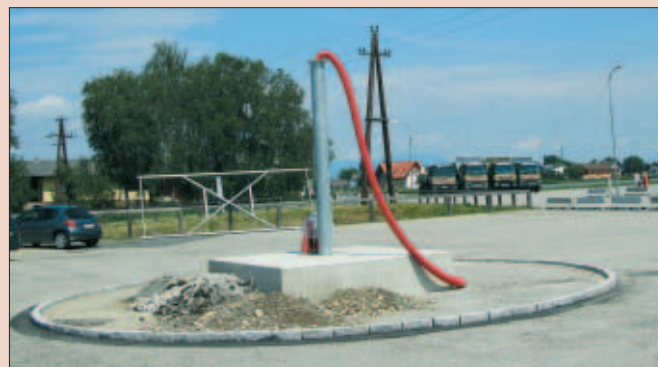
Die Firma Ofner in Kasten errichtet auf ihrem Firmengelände ebenfalls eine Photovoltaikanlage.
