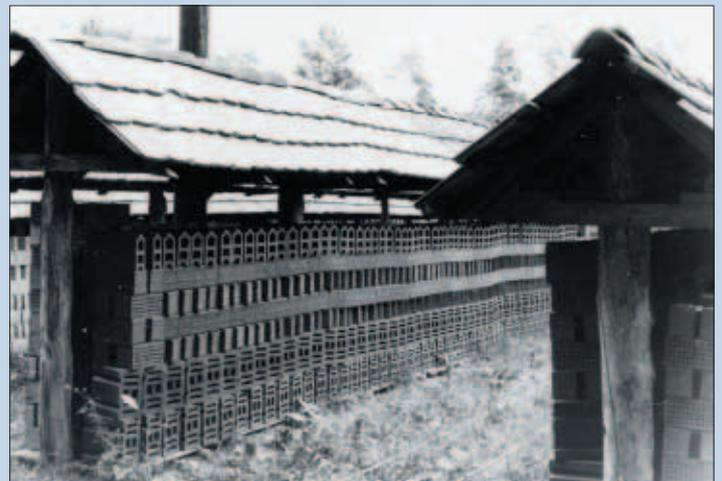
Lufttrocknung der Ziegel in den Trockenhäuschen.
