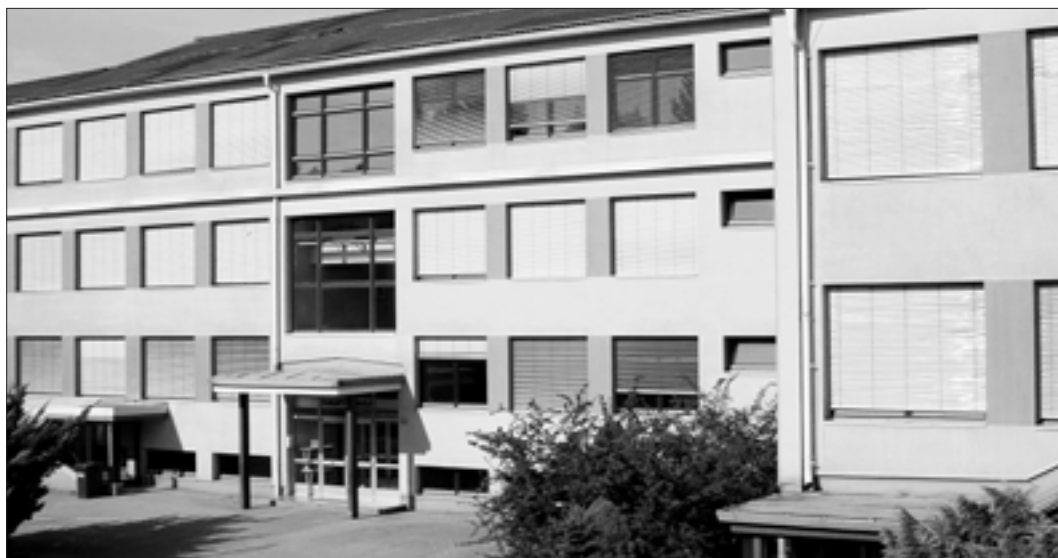
Die Volks- und Hauptschule in Unterpremstätten wird umgebaut. Die Fertigstellung ist im Herbst 2004 vorgesehen. Der Spatenstich hat bereits stattgefunden.
