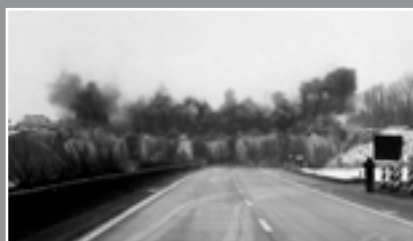
Sprengung der Brücke.
