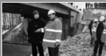
Ing. Vennemann besichtigt die gesprengte Brücke.
