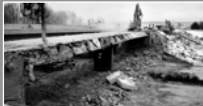
Bohrlöcher werden angebracht, Brücke teilweise schon abgerissen.
