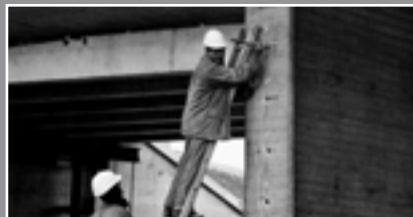
Die Bohrlöcher werden mit Sprengstoff gefüllt.
