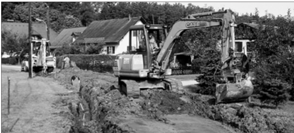
Bei den Bauarbeiten im Teichweg.
