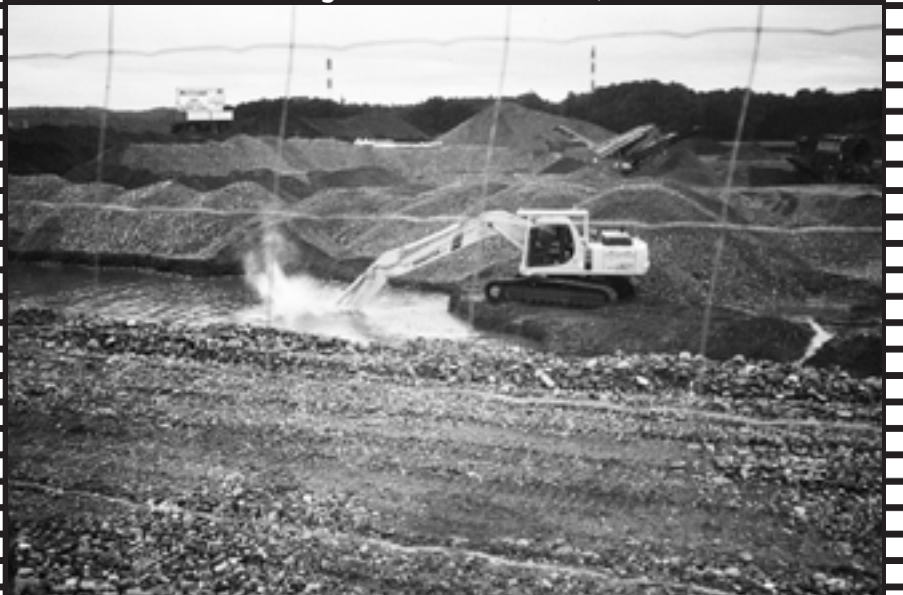
Schon nach wenigen Wochen wurde der Schotter aus dem Grundwassersee herausgebaggert.
