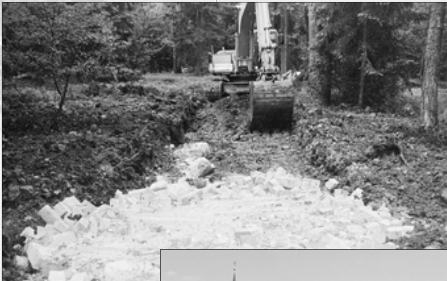
Mit dem Bauschutt des Pfarrheims wurde ein Muster-Waldweg angelegt.
