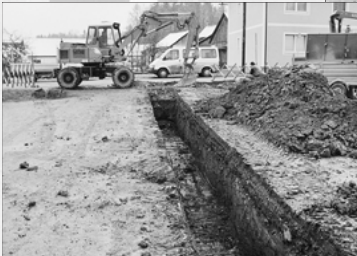
In einem Arbeitsgang wurden Kanal-, Wasser-, Strom- und Postleitungen verlegt.
