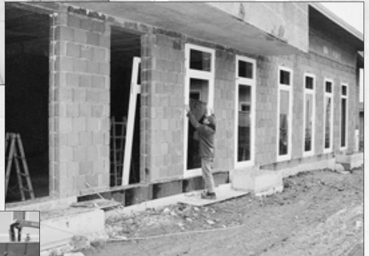
Die Fenster werden montiert.
