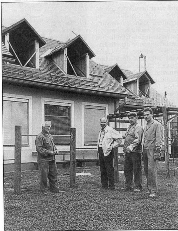
Bauleiter Alfred Likawetz mit drei Helfern (Strohriegl, Berger, Strasser).
