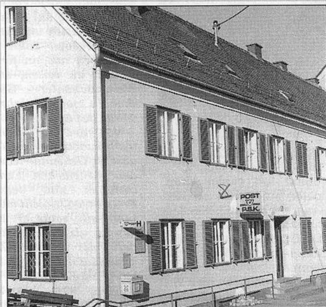
Im Jahr 1986 wurde das Haus Wundschuh 96 von der Gemeinde saniert.
