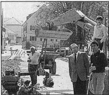
Mit großer Geduld nahm die Gemeindebevölkerung die durch den Ortswasser- und Kanalbau notwendig gewordenen Aufgrabungsarbeiten hin. Im Zuge des Kanalbaus wurden dann in den Ortschaften Forst, Kasten und Gradenfeld alle Straßen neu asphaltiert.
