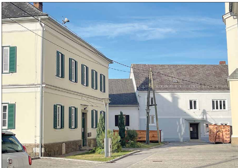
Dieses Bild gehört schon bald der Vergangenheit an, denn der Abbruch des alten Gebäudes ist schon der nächste Schritt.
