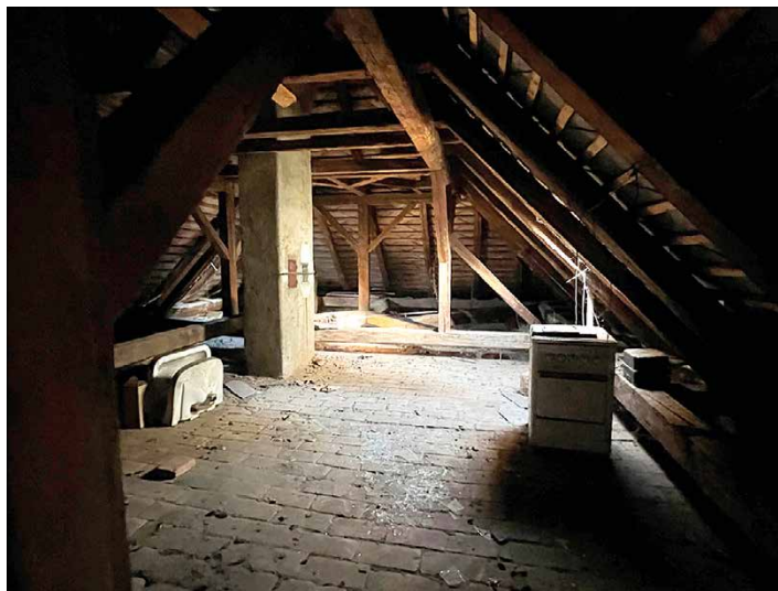
Ein Blick in den Dachboden. Auch dieser geheimnisvoll anmutende Raum ist bald verschwunden.
