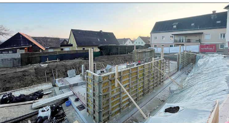
Der vordere Bereich des neuen Gemeindeamts ist voll unterkellert.
