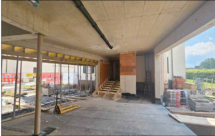
Im Foyer wurde eine Verbindung in den Pfarrhof geschaffen. Rechts von der Stiege befindet sich ein barrierefreies WC.
