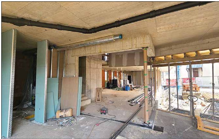
Ein Blick vom Foyer in den zukünftigen Bürgerservicebereich. Eine Schiebetür trennt diesen Bereich vom Foyer.
