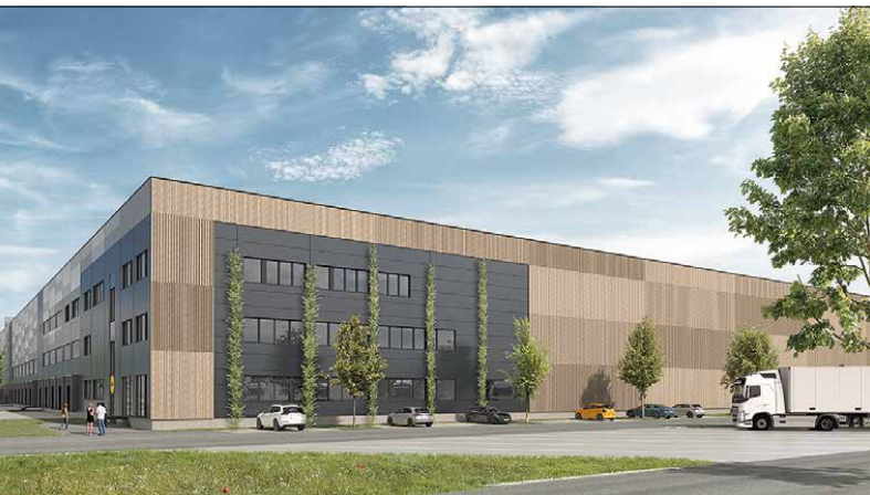
Das Ortsbild ist besonders wichtig. So sind beim neuen Lidl-Logistikzentrum Holzfassaden und Fassadenbegrünungen vorgesehen.
